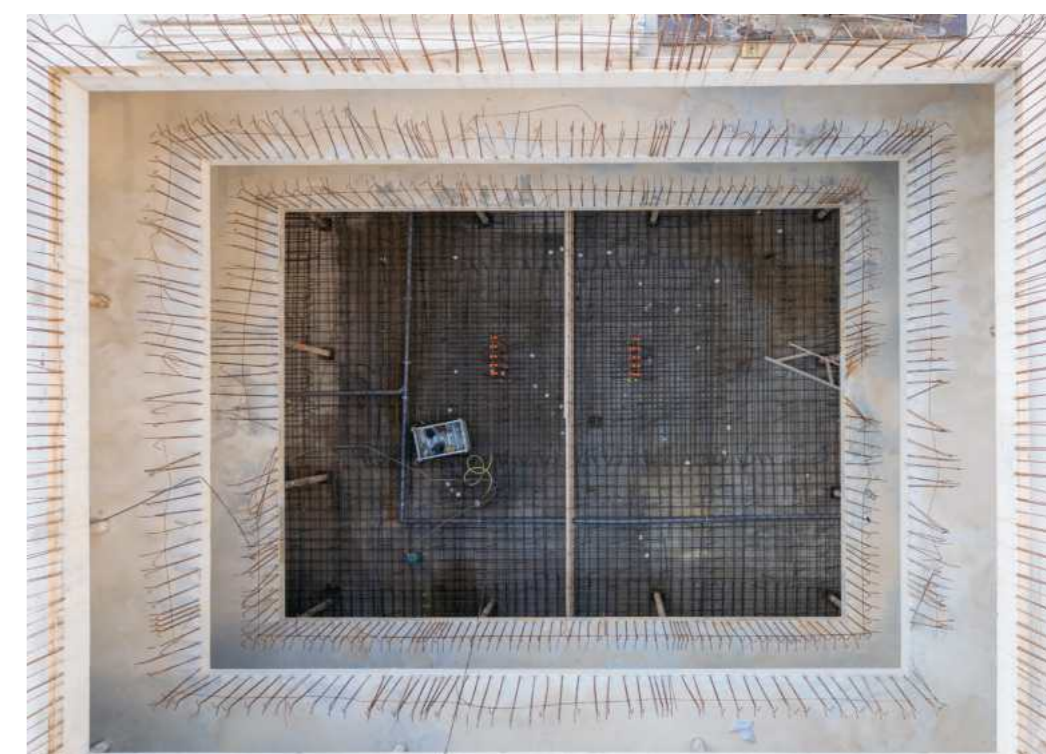
Foro realizzato nei solai di dimensione 6x5 metri
